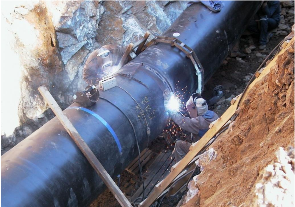
Заваряване на газопровод високо налягане
