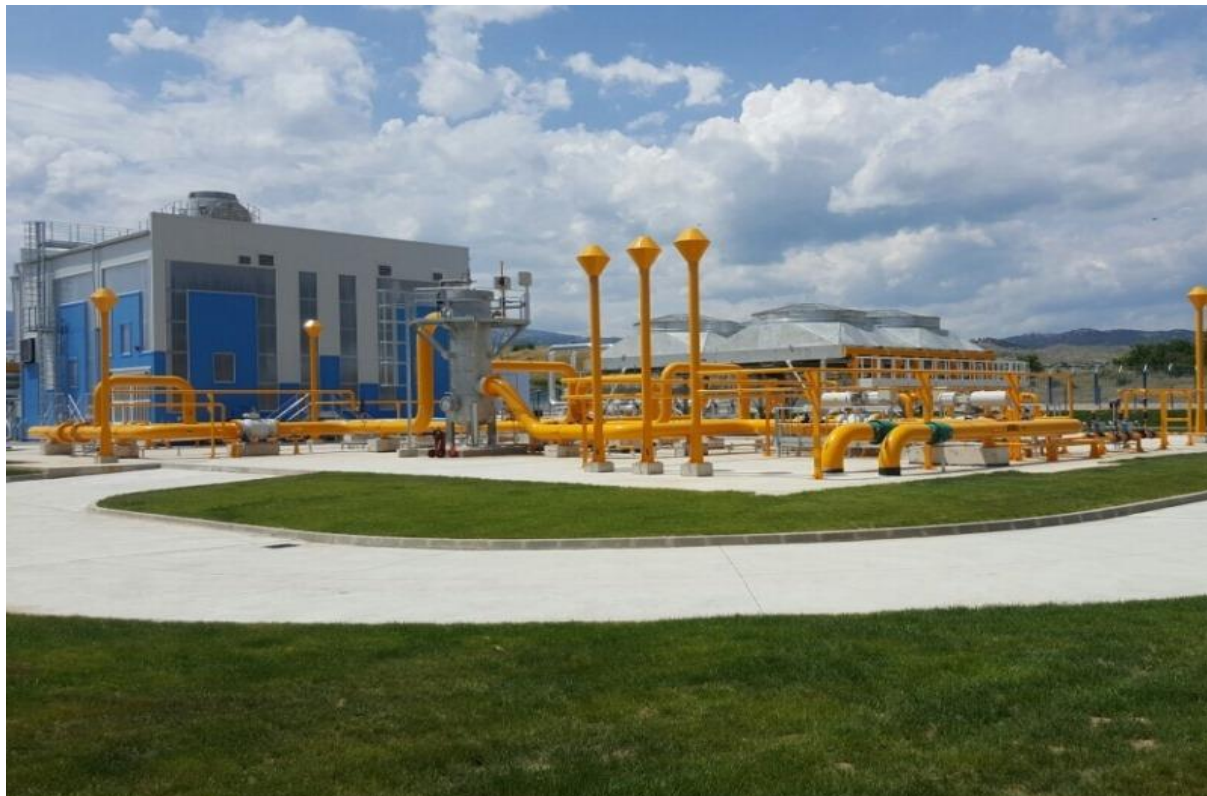
Компресорна станция „Ихтиман“
