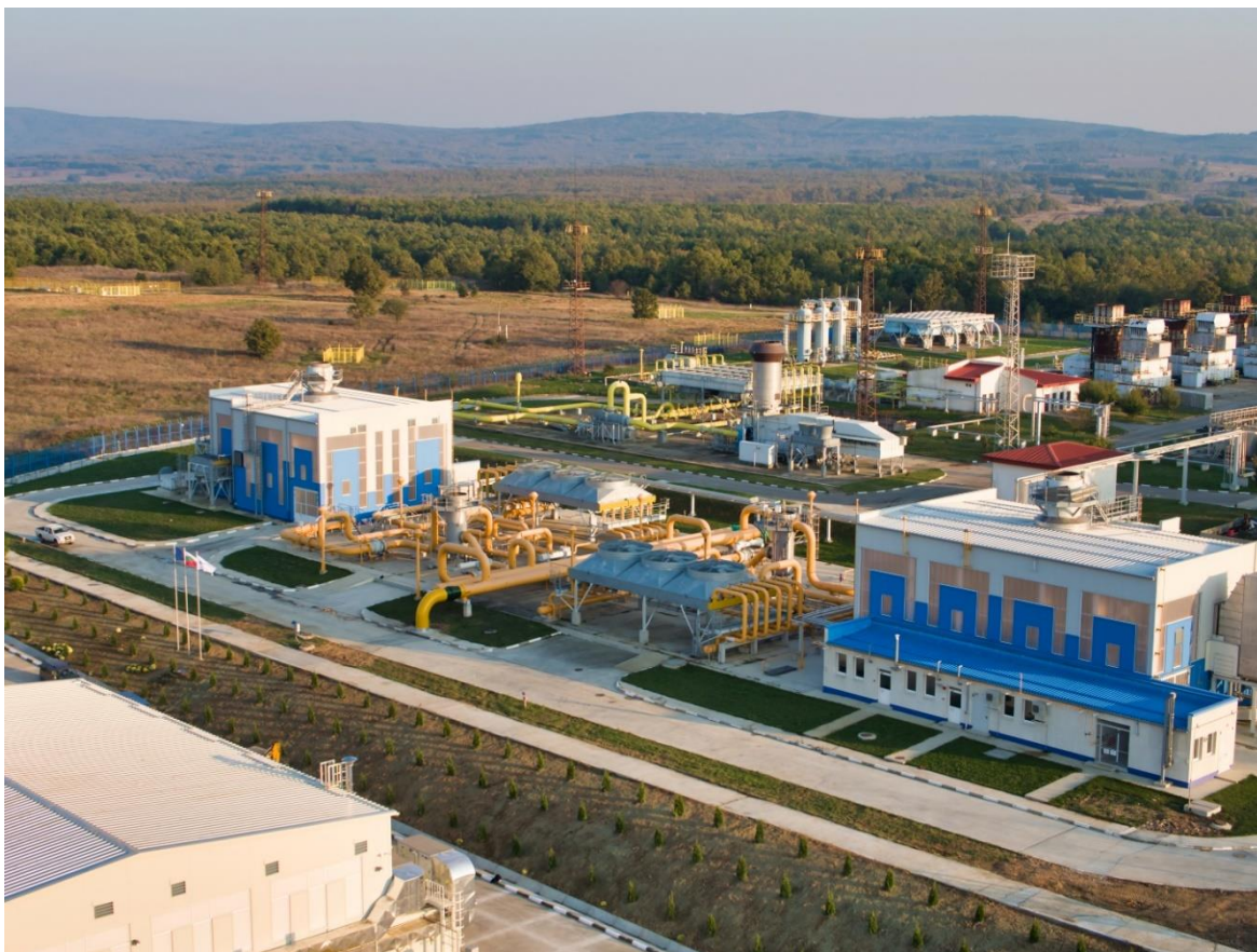
Компресорна станция „Странджа“
