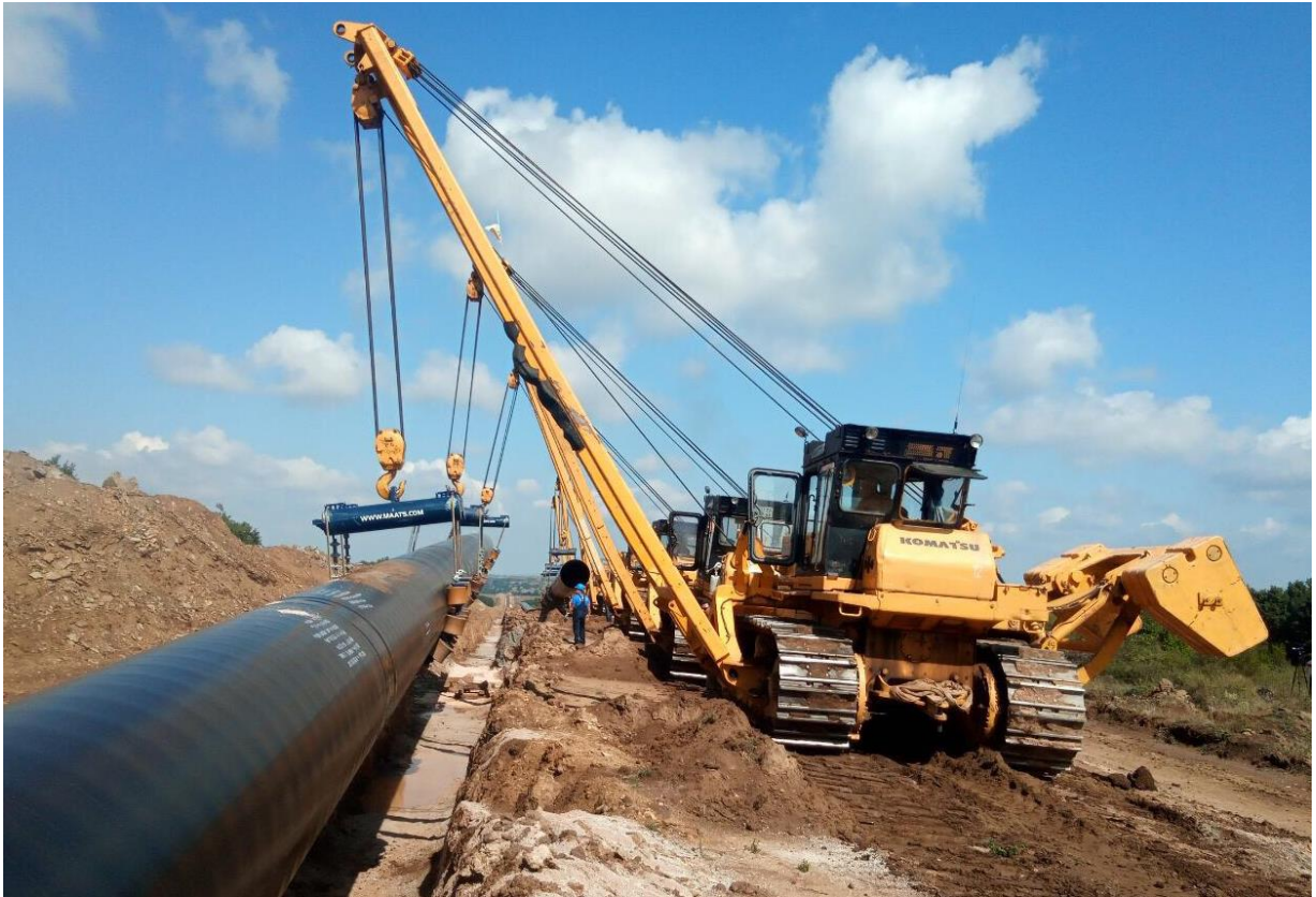
Строителство на линейна част на газопровод високо налягане
