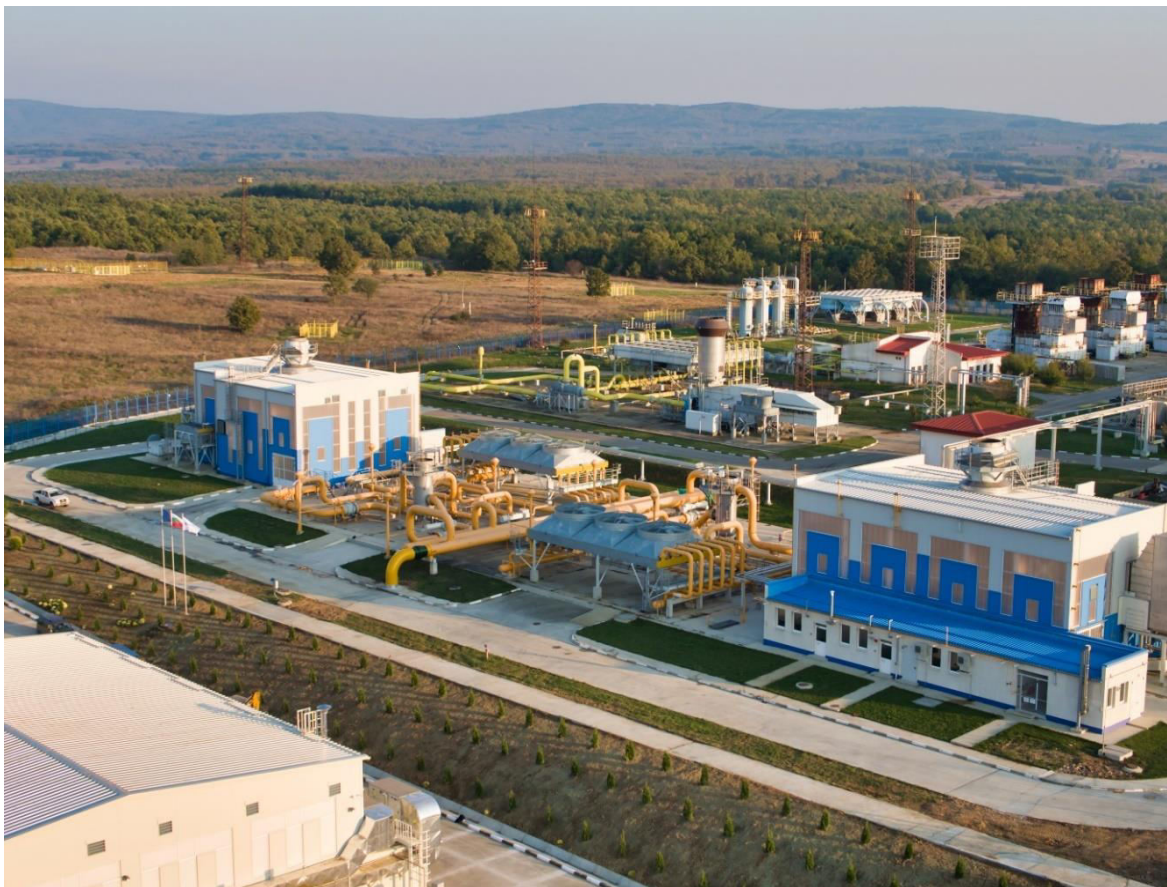
Компресорна станция „Странджа“
