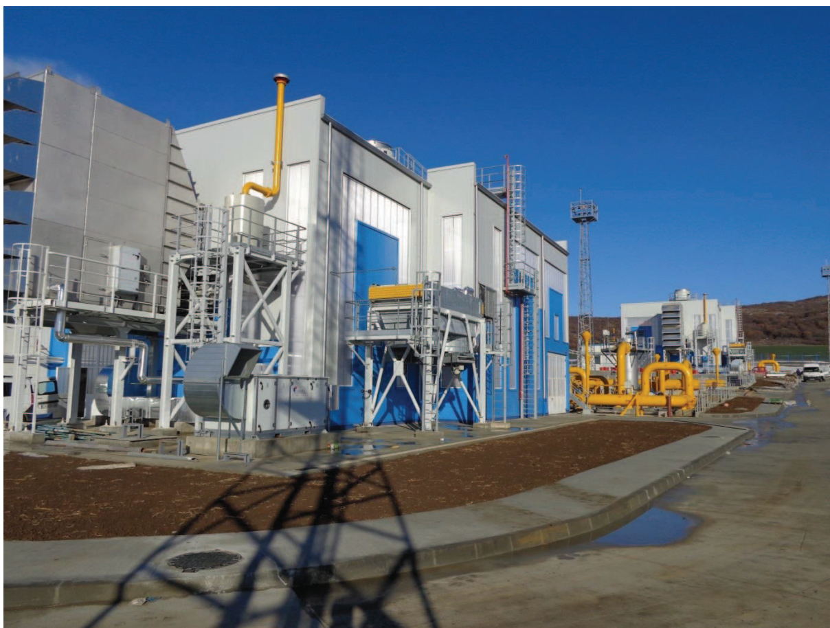
Компресорна станция „Лозенец“
