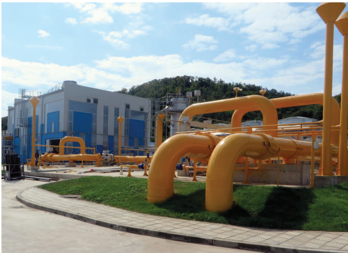
Компресорна станция „Ихтиман“
