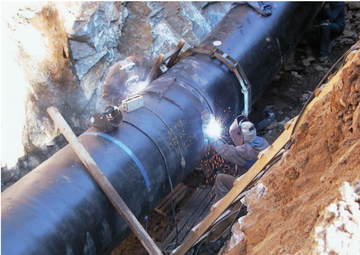
Заваряване на газопровод високо налягане
